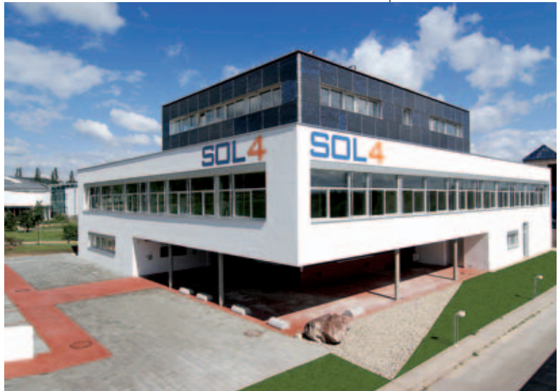
«SOL4»-Passivbürohaus in Mödling (A)
