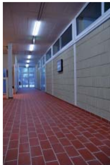
Klinkerboden und Sicht-Lehmwände im Erdgeschoss
